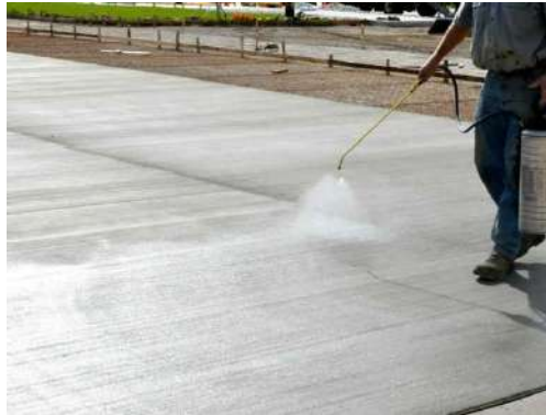
Gambar 2. 8 Perawatan Beton (Sumber : Internet)
