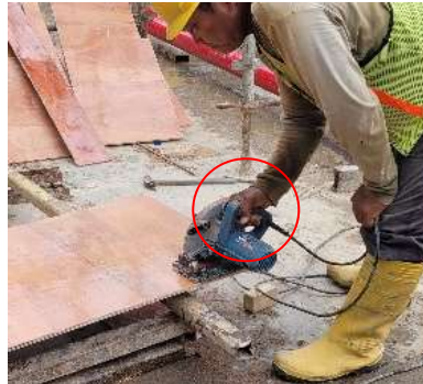
gambar 4. 28 Menggenggam dengan kuat dalam posisi power grip
