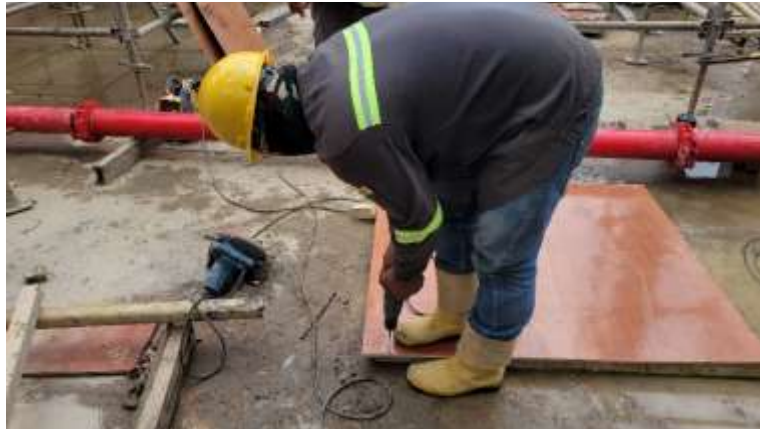
Gambar 4. 4 Pekerjaan Pemasangan Kayu Pada Pondasi
