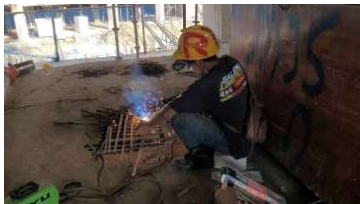
gambar 4. 45 Postur Kerja Pengelasan Besi Rebar Sebelum dilakukan Perbaikan Fasilitas Kerja
