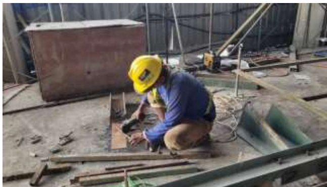
gambar 4. 49 Postur Kerja Pengelasan Besi Rebar Sebelum dilakukan Perbaikan Fasilitas Kerja
