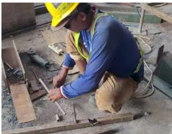
gambar 4. 24 Pengangkatan manual pemotongan besi rebar
