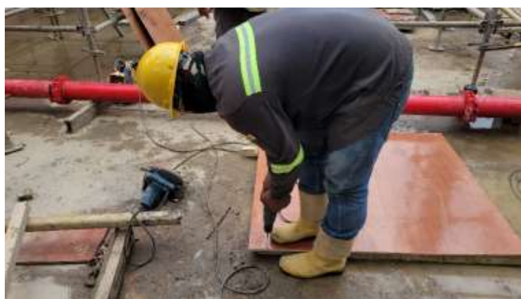
gambar 4. 62 Postur Kerja Pemasangan Kayu Sebelum dilakukan Perbaikan Fasilitas Kerja
