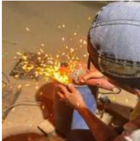
Gambar 4. 32 Pembuatan Ruang Scrubber
