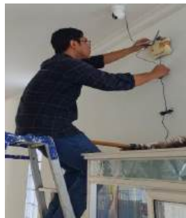
Gambar 4.14. Pemasangan CCTV Router, dan seluruh sistem lainnya Sumber: Pribadi
