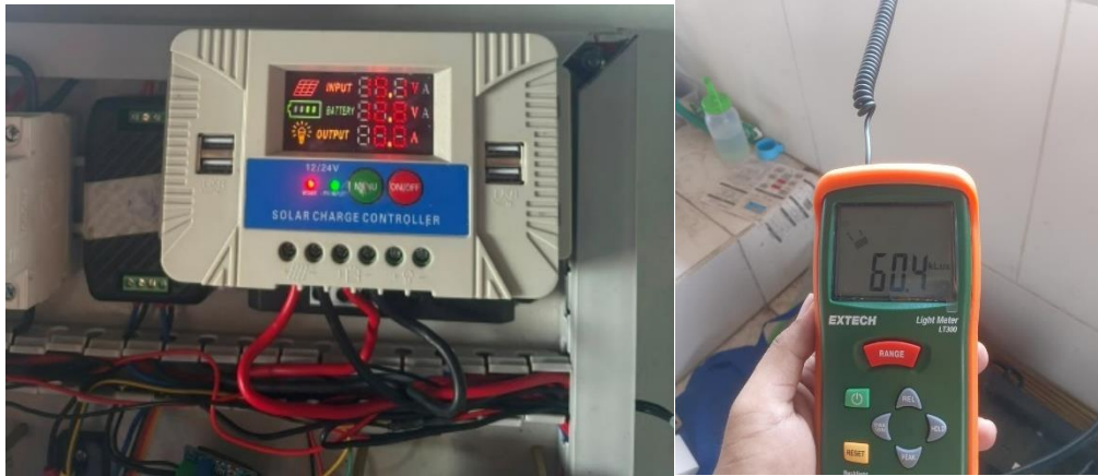
Gambar 4. 2 Pengujian Pv Tanpa Beban Menggunakan Alat ukur dan Sensor
