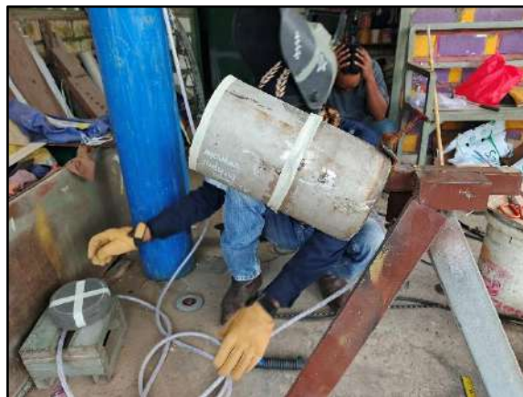
Gambar 3. 7 Proses Pemasangan Spon untuk Backing Gas
