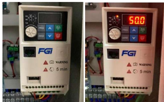
Gambar 4. 16 Kondisi saat Inverter mati dan Kondisi Inverter menyala.
