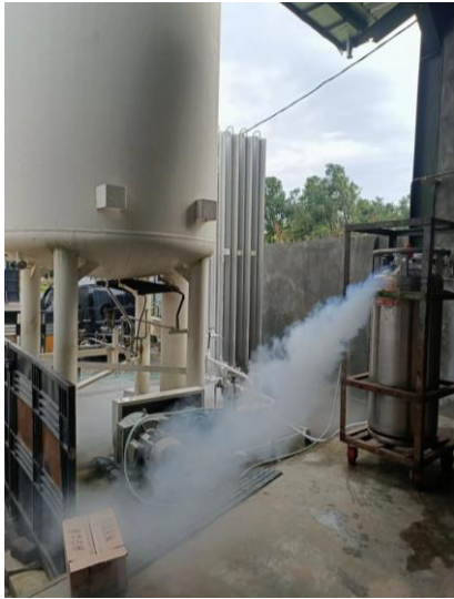
Foto Saat Pengisian Liquid ke Dalam Tabung Gas
