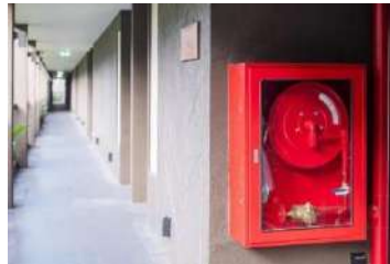
Gambar 2. 10 Hidran Gedung (sumber: firefix.co.id)
