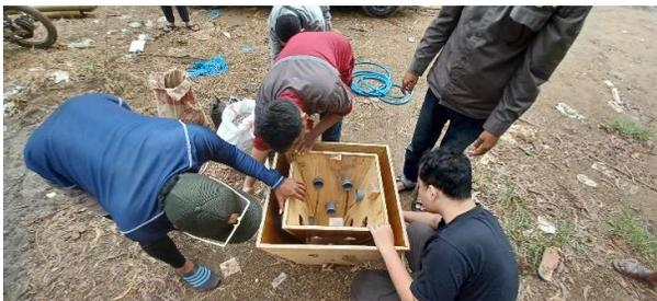
Gambar 5 Pemasangan pipa pembentuk lubang di cetakan
