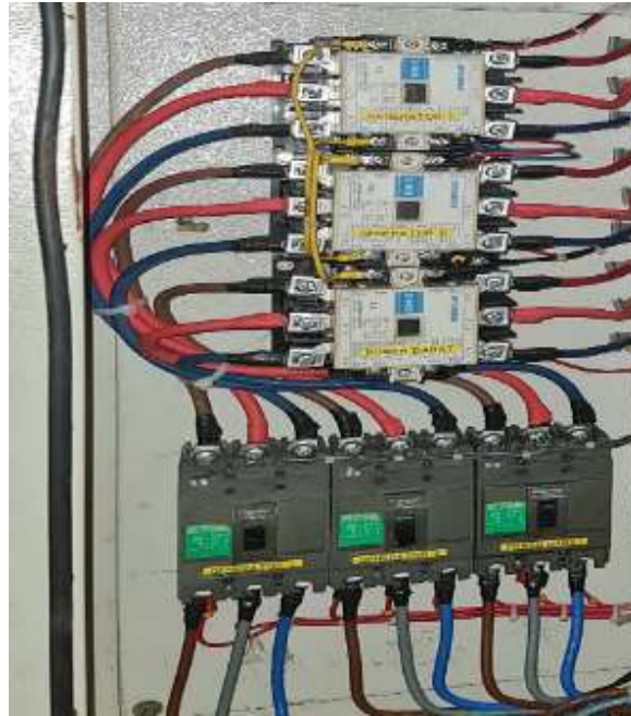
Gambar 3. 5 MCCB terhubung ke Kontaktor
