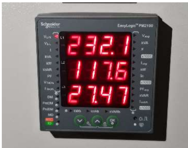
Gambar 4. 2 Pengujian Power Meter dengan tegangan L-N 220 Volt
