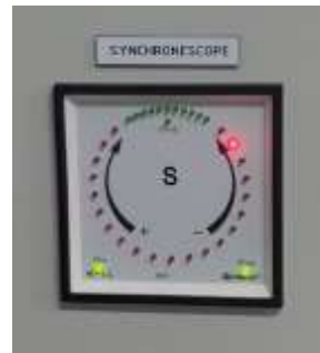
Syncro Indicator Lamp Berputar dengan Cepat
