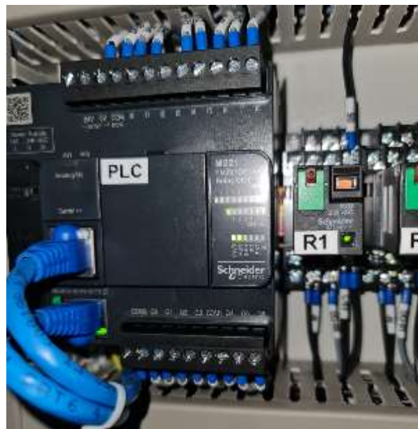
Gambar 4. 10 Ketika PLC output Q0 memerintahkan Relay R1 aktif
