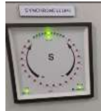
Syncroscope saat ke dua sumber sudah siap digabung
