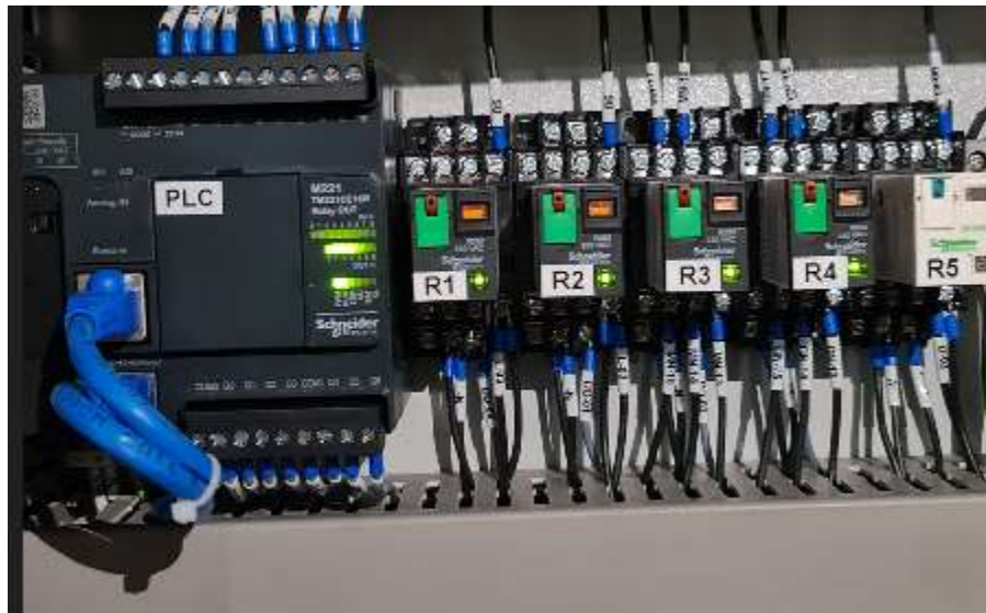
Gambar 4. 11 Ketika PLC output Q0-4 memerintahkan Relay R1- 4 aktive
