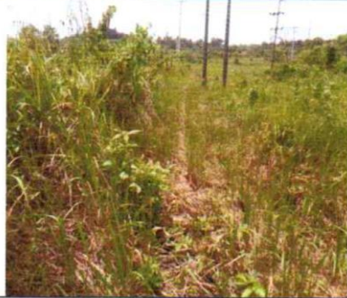
Pipa tertimbun rumput dan ilalang, saat clearing tidak di singkirkan.
