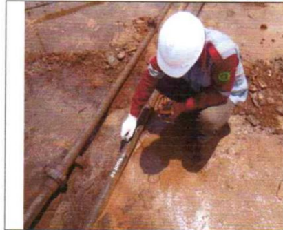
Pengambilan Thickness pada pipa flowline
